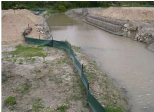
ภาพที่ 5.2.1-1 ตัวอย่างการติดตั้งรั้วตักตะกอนแบบ Temporary Silt Fence
