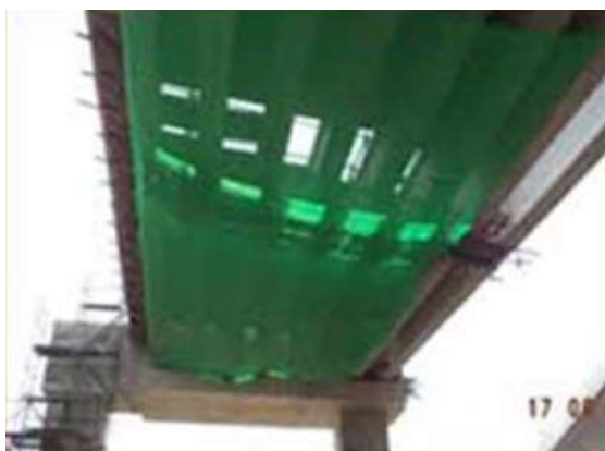
ภาพที่ 5.2.1-3 ตัวอย่างการติดตั้งผ้าใบหรือตาข่ายรองรับเศษวัสดุจากการรื้อย้ายและก่อสร้างสะพาน
