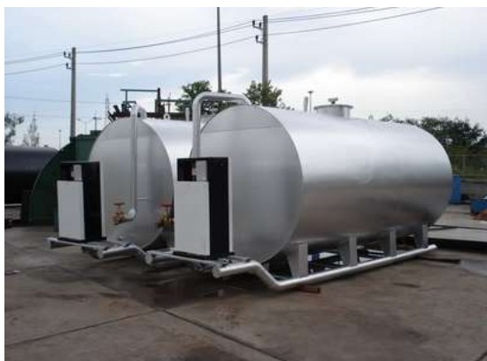
ภาพที่ 5.2.1-2 ตัวอย่างการเทพื้นคอนกรีตในบริเวณที่อาจเกิดการรั่วไหลของน้ำมันและไขมัน
