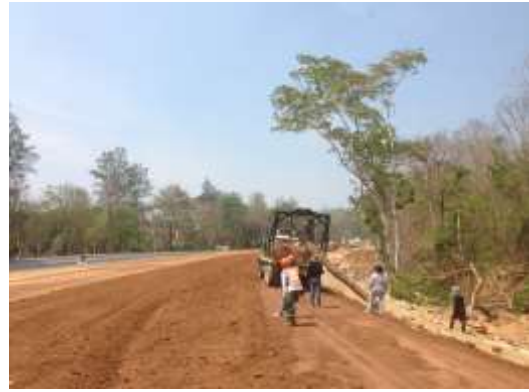
ภาพที่ 5.2.2-1 การทำเครื่องหมายตัดฟันต้นไม้ในเขตทาง และการควบคุมทิศทางการล้มของไม้
