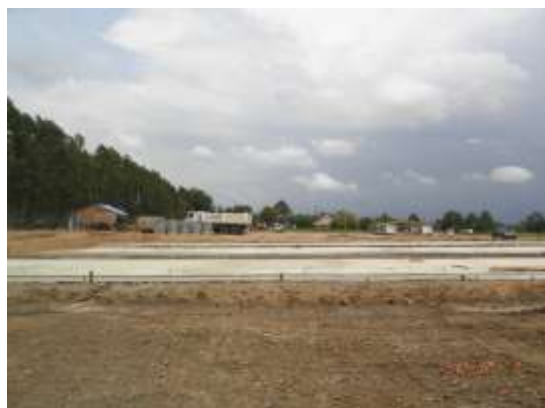
ภาพที่ 5.2.1-2 ตัวอย่างการเทพื้นคอนกรีตในบริเวณที่อาจเกิดการรั่วไหลของน้ำมันและไขมัน
