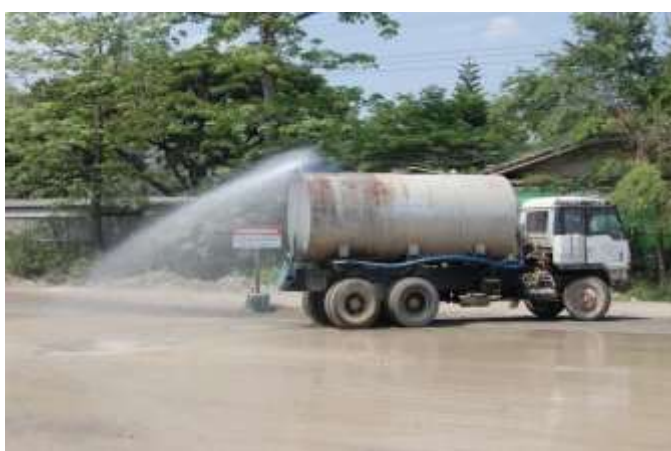
ภาพที่ 5.2.1-4 ตัวอย่างการฉีดพรมน้ำบริเวณพื้นที่ก่อสร้าง
